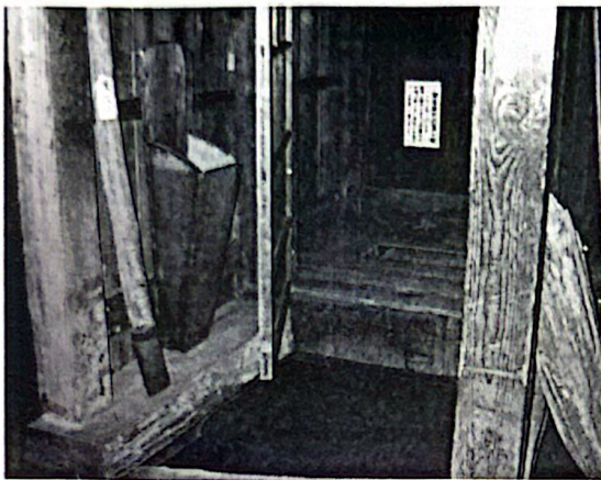
兵屋トイレ付近
