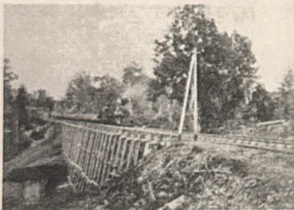
げんおおあさにしまちこうえんあた さわ か りくきょう 現大麻西町公園辺りの沢に架けられた陸橋
